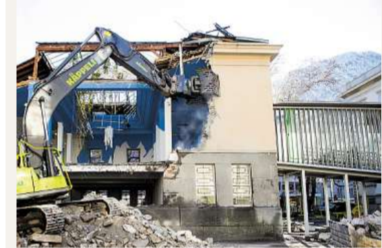
Noch stehen Sulserbau und Passarelle. (OI)
